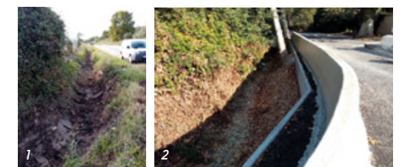
1 - Curage et fauconnage d'un fossé de drainage pluvial
